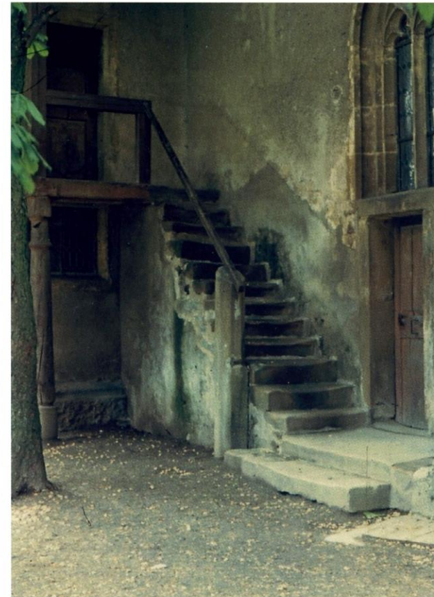
Aufgang zum Amtsstuhl, Südseite, wurde 1955 entfernt
